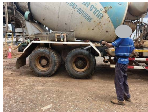
8. การล้างล้อรถบรรทุกที่เข้า-ออกพื้นที่โครงการ
